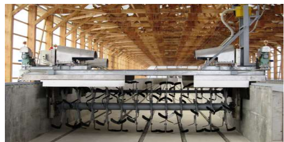
発酵槽F1 (1次発酵槽), 攪拌機ツインローター回転刃
