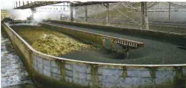
発酵槽F1 (1次発酵槽), 全長25~70m、深さ1.3~1.5m、幅8.3m
